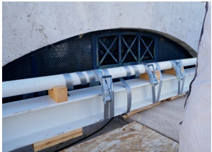
Die silbergrauen Zurrgurte halten Unterkonstruktion und die Stangen, an denen das Gewebe befestigt wird, zusammen.
